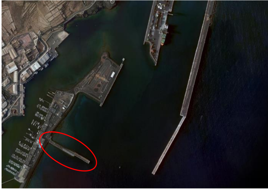
Ortofoto del puerto de Arrecife, con el proyecto del nuevo contradique ejecutado (en rojo)
