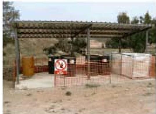
La zona de almacenamiento temporal de los residuos peligrosos en la obra, se acondicionará sobre solera de hormigón o sobre bandejas de recogida de derrames, de forma que no se encuentre en contacto directo sobre el suelo, tratando en la medida de lo posible segregarlos por su toxicidad o peligrosidad.
